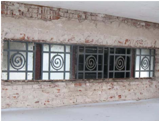
VISTAS POR ENCIMA DEL CIELORRASO
