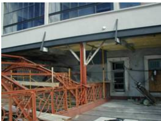
Fig. 26, 27 y 28 – Apuntalamiento de fachada y colocación del perfil - Esquema estructural de la solución
