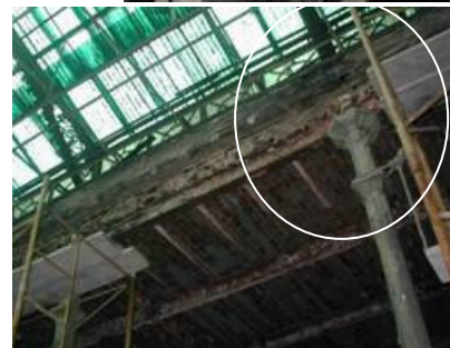
Fig. 35, 36, 37, 38, 39, 40 Y 41 – Solución de vínculo hacia abajo y situación existente- Transmisión de la carga Tramo de empalme que además debió corregir el desplome entre el eje del pilar superior, y el del inferior.
