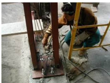
Fig. 31, 32, 33, y 34 – Refuerzo de pilares con estructura reticular y bases de H.A
