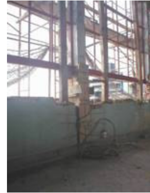
3 Fig. 29 y 30 – Intervención en los antepechos para vincular y rigidizar todo el bloque
