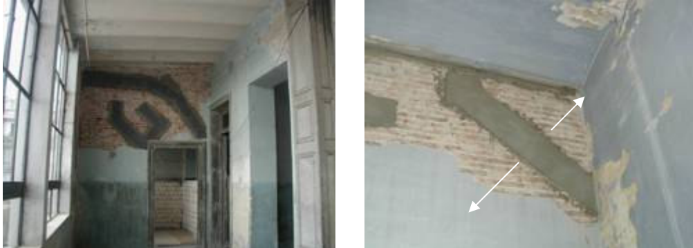
Fig. 42 y 43 – Refuerzo de muros transversales
