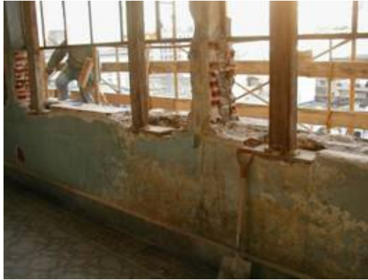
3 Fig. 29 y 30 – Intervención en los antepechos para vincular y rigidizar todo el bloque
