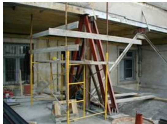
Fig. 31, 32, 33, y 34 – Refuerzo de pilares con estructura reticular y bases de H.A
