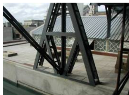
Fig. 31, 32, 33, y 34 – Refuerzo de pilares con estructura reticular y bases de H.A
