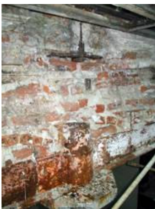
Fig. 35, 36, 37, 38, 39, 40 Y 41 – Solución de vínculo hacia abajo y situación existente- Transmisión de la carga Tramo de empalme que además debió corregir el desplome entre el eje del pilar superior, y el del inferior.
