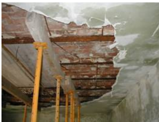
Fig. 10 y 11 – Apuntalamiento y refuerzo en sub-suelo
