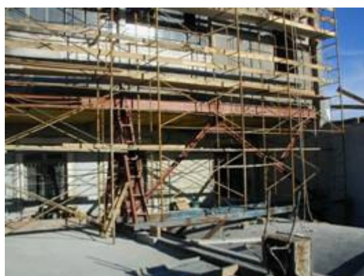
Fig. 26, 27 y 28 – Apuntalamiento de fachada y colocación del perfil - Esquema estructural de la solución
