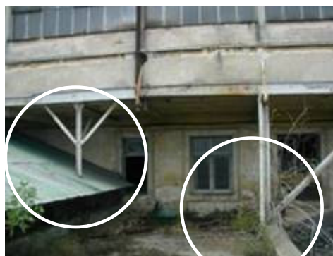
Fig. 24 y 25 – Corte transversal y vista de la descarga de los dos pisos sobre la claraboya
