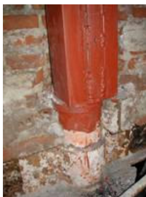
Fig. 35, 36, 37, 38, 39, 40 Y 41 – Solución de vínculo hacia abajo y situación existente- Transmisión de la carga Tramo de empalme que además debió corregir el desplome entre el eje del pilar superior, y el del inferior.
