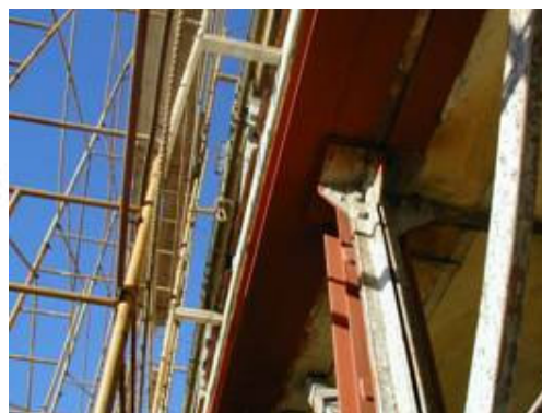
Fig. 26, 27 y 28 – Apuntalamiento de fachada y colocación del perfil - Esquema estructural de la solución
