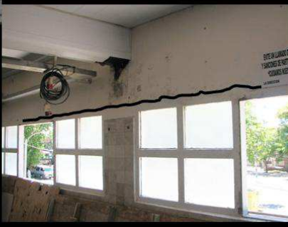
DEFORMACIÓN DE V117 (luz 14 m) POR LA NUEVA FORMA DE TRABAJO. FISURA EN DINTEL.
