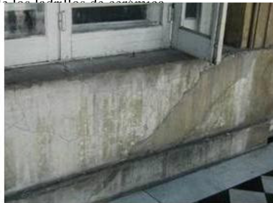
Fig.33-fisuras reparadas
