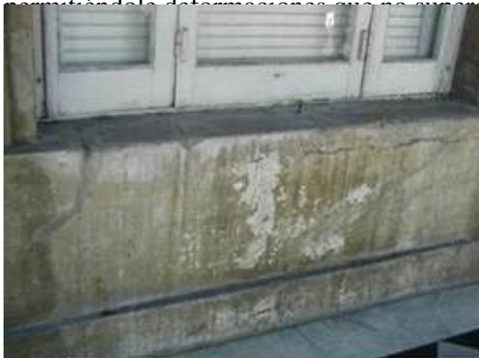
Fig. 32 - antepecho fisurado
