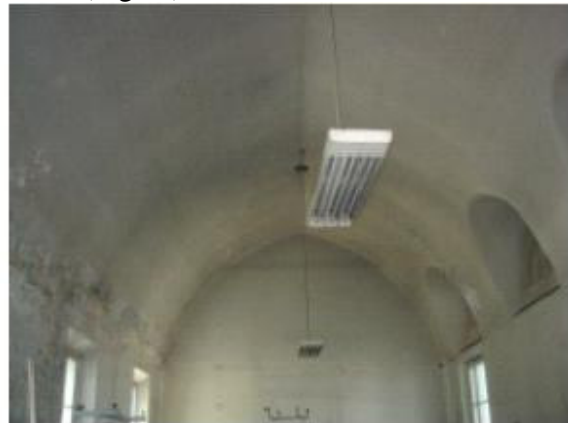
Fig.12 – bóveda de medio punto
