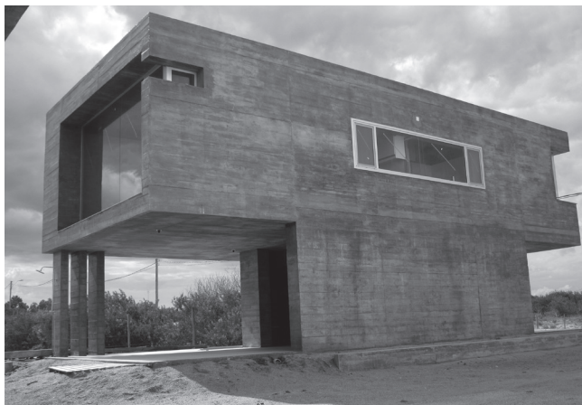
Construcción en Rocha
