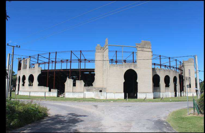
Paredes y arcos fisurados y con desplome
