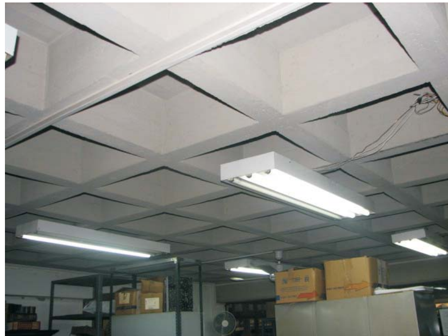
Fig.46 - Vista general de la losa nervada
