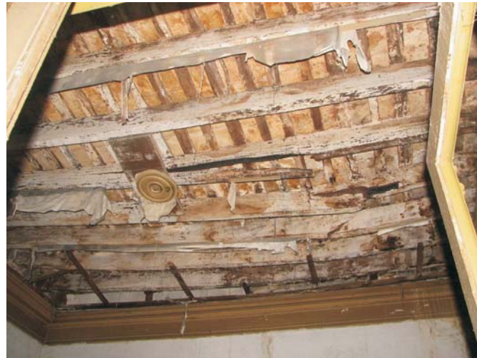
TIRANERÍA COLAPSADA
