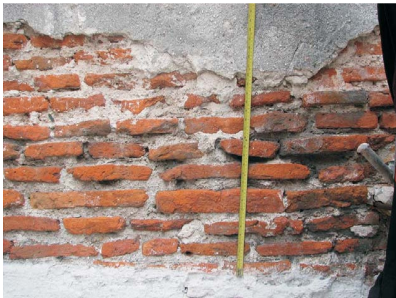
DISPARIDAD DE MEDIDAS (MAMPUESTOS Y JUNTAS)
