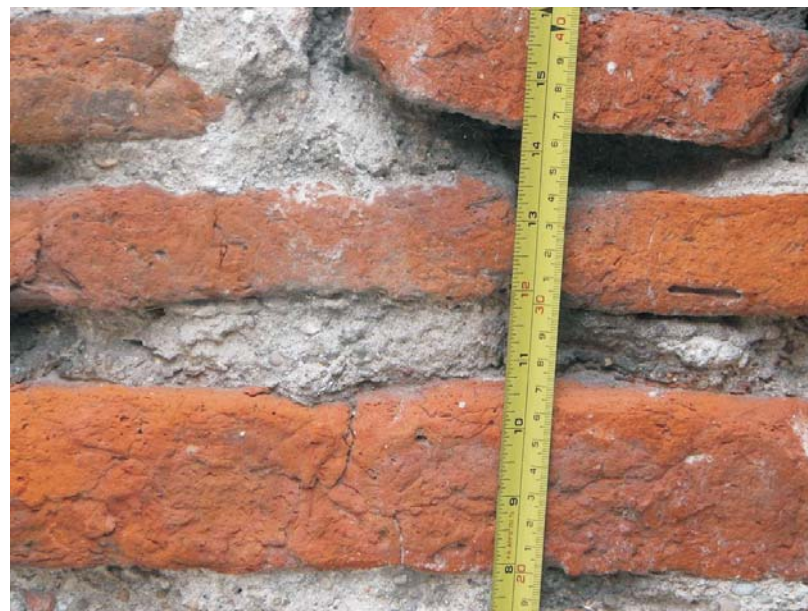
DISPARIDAD DE MEDIDAS (MAMPUESTOS Y JUNTAS)
