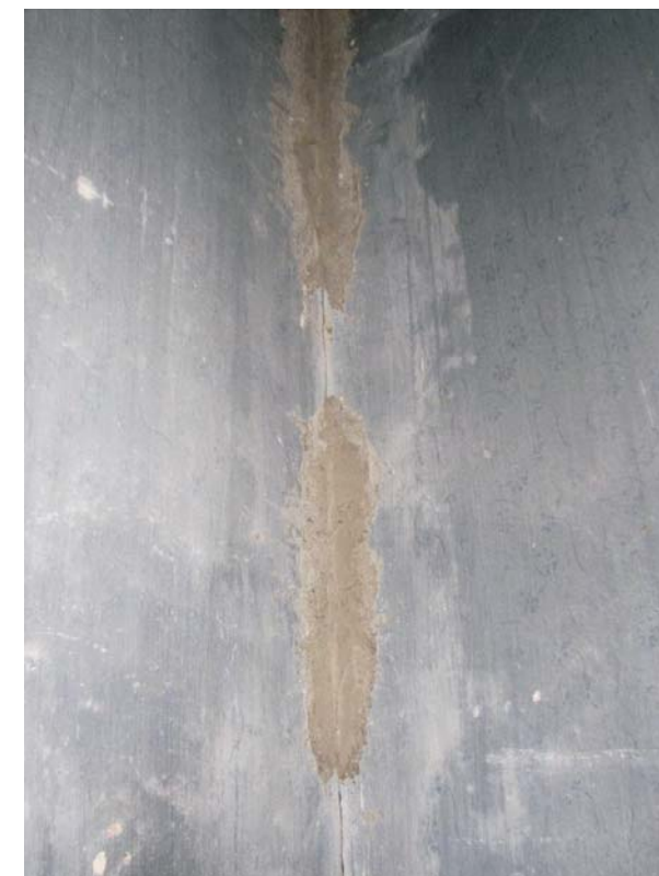
TESTIGO FISURADO
