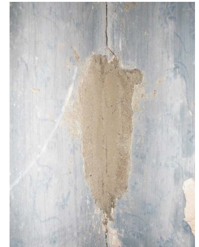
TESTIGO FISURADO
