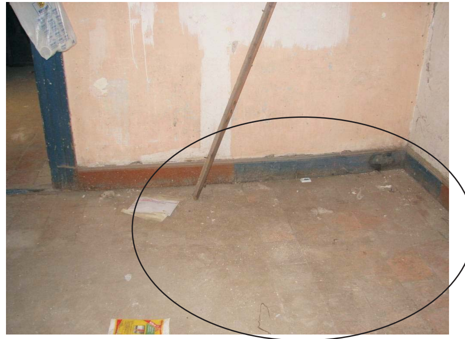
PAVIMENTO DEL ENTREPISO HUNDIDO
