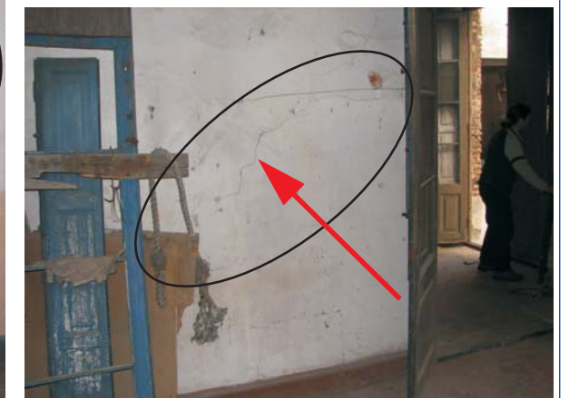
MURO FISURADO
