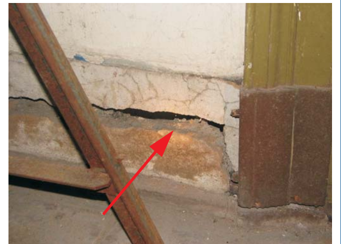
MURO DESCALZADO
